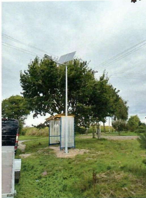
Zakup instalacji służącej użyteczności publicznej - budowa oświetlenia z zastosowaniem technologii LED w sołectwie Mogielnica
