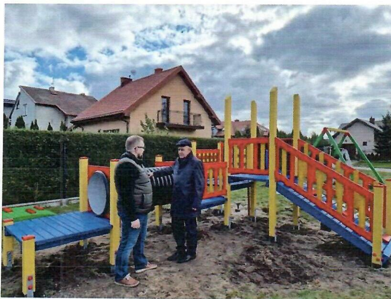
Budowa placu zabaw przy ul. Kryskich w Drobinie
