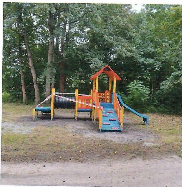
Budowa placu zabaw w sołectwie Biskupice
