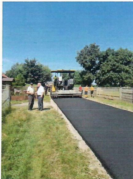
Przebudowa drogi gminnej Nr 290525W w miejscowości Kozłowo-Kozłówko-Łęg Probstwo – V etap
