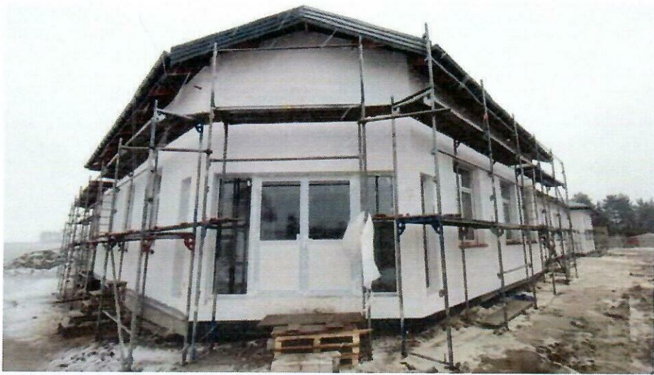
Budowa budynku publicznego przedszkola z infrastrukturą towarzyszącą w Łęgu Kościelnym
