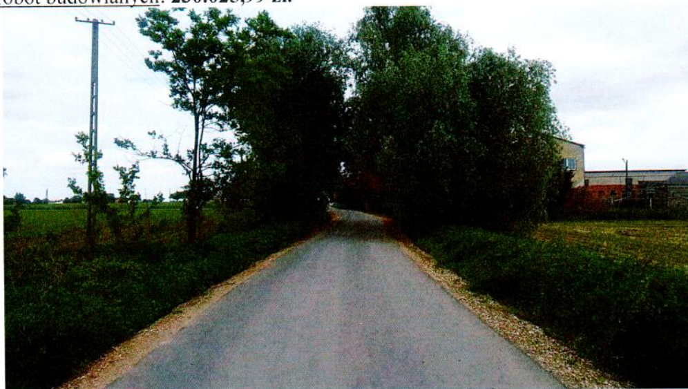
Przebudowa drogi gminnej w Mogielnicy
