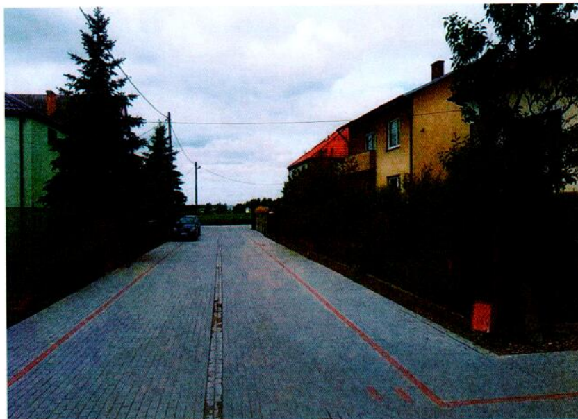
Przebudowa drogi gminnej – osiedle domków jednorodzinnych w Łęgu Probostwie
