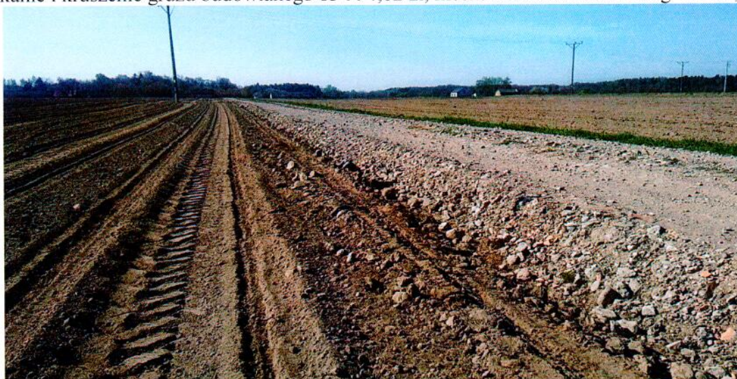
Utwardzenie drogi gruzem budowlanym we wsi Kozłówko
