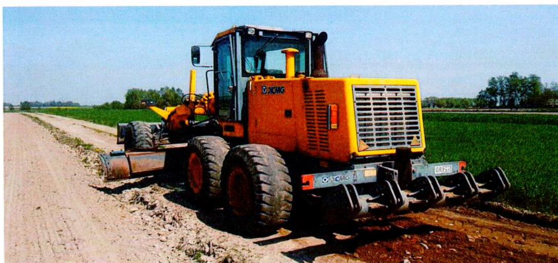
Praca równiarki na drodze gminnej
