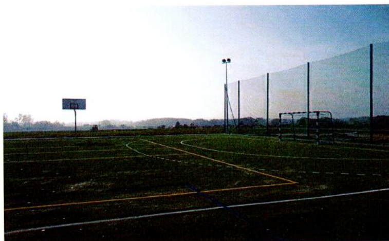
Budowa boiska wielofunkcyjnego w Rogotwórsku
