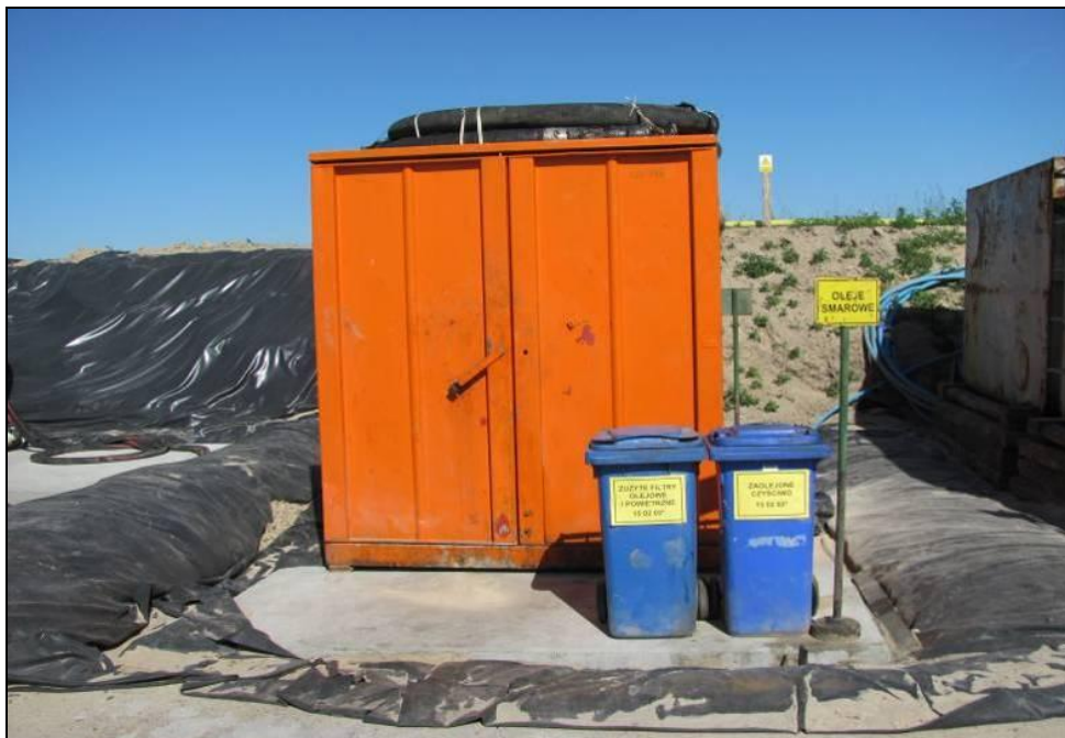
Fot. 34 Zabezpieczenie terenu wiertni folią PEHD izolującą środowisko gruntowo – wodne od zanieczyszczeń z powierzchni terenu. (Arch. PGNiG SA)
