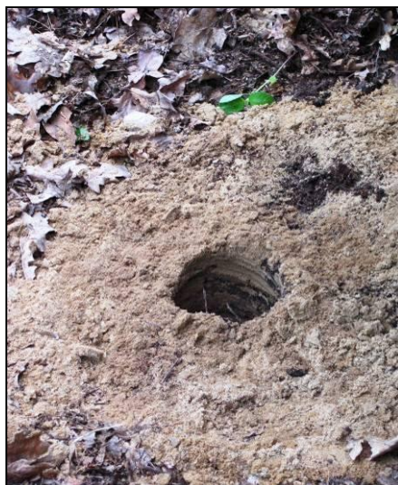
Fot. 12 Gotowy do założenia ładunku wybuchowego otwór strzałowy. (Arch. PGNiG SA)
