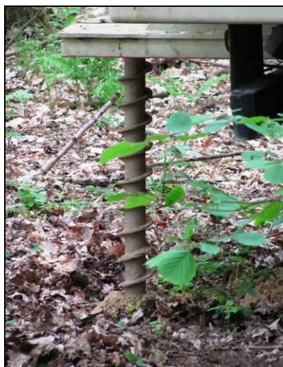
Fot. 11 Wiercenie otworu strzałowego. (Arch. PGNiG SA)
