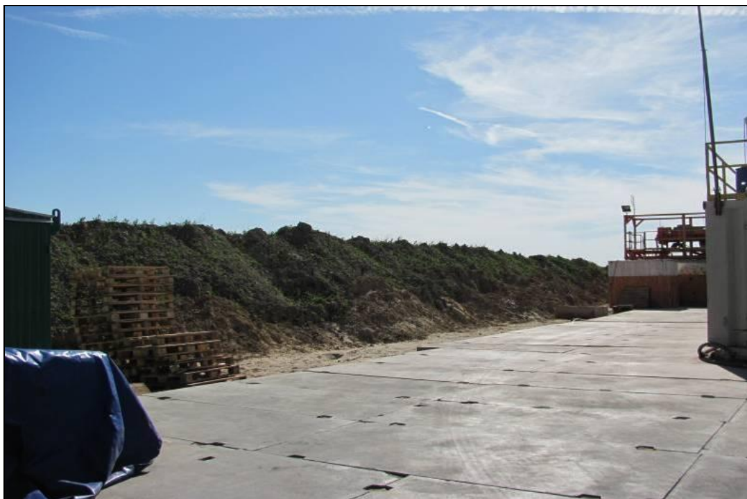
Fot. 32 Fragment wału ziemnego (pryzma z wierzchniej warstwy gleby), okalający teren wiertni oraz nawierzchnia z płyt betonowych. (Arch. PGNiG SA)
