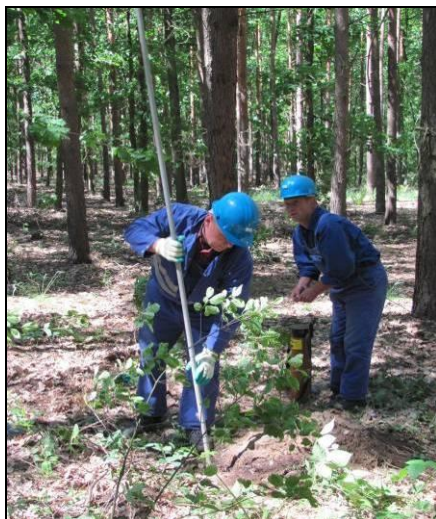
Fot. 21 Sprawdzanie głębokości otworu strzałowego. (Arch. PGNiG SA)
