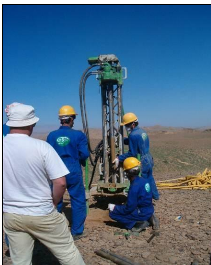
Fot. 10 Ręczne urządzenie do wiercenia płytkich otworów strzałowych. (Arch. PGNiG SA)
