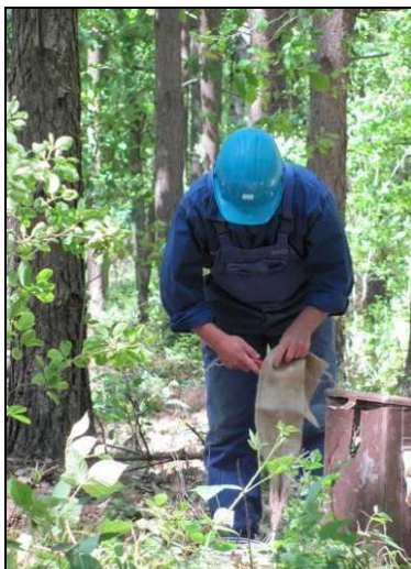
Fot. 23 Uzbrojony ładunek wybuchowy jest wkładany do lnianego worka, w celu ochrony łatwiejszego umieszczenia go w otworze strzałowym. (Arch. PGNiG SA)
