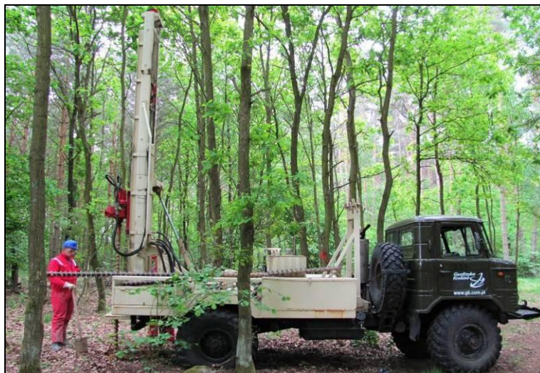
Fot. 8 Samojezdne urządzenie do wiercenia otw, strzałowych w trakcie pracy. (Arch. PGNiG SA)
