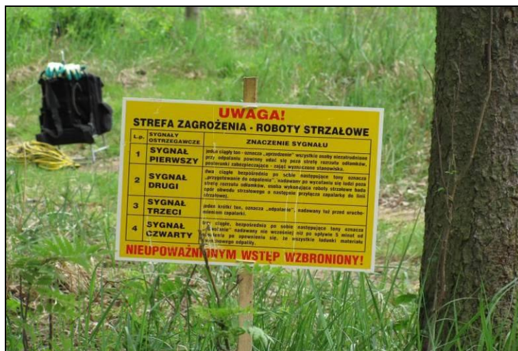
Fot. 14 Oznaczenie terenu prac sejsmicznych z użyciem materiałów wybuchowych – tablica ostrzegawcza. (Arch. PGNiG SA)
