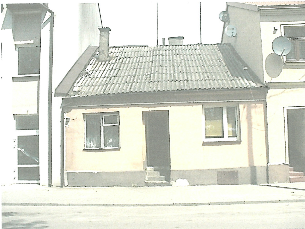
Zdjęcie nr 1 – Drobin, ul. Rynek 34- elewacja frontowa
