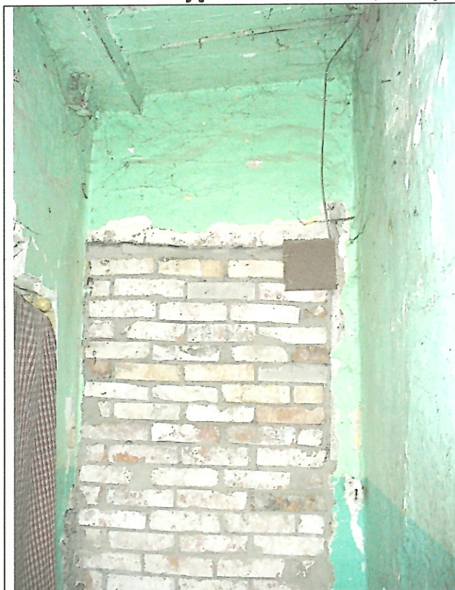
Zdjęcie nr 4 – widok stropu nad parterem
