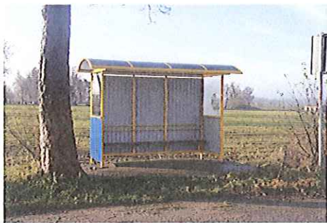
Wiata przystankowa przy drodze powiatowej Łęg - Mogielnica na terenie sołectwa Łęg Kościelny
