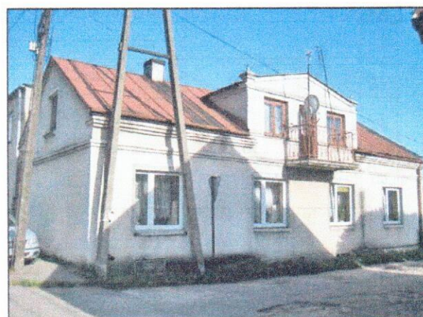
Fot. 16. Budynek mieszkalny z XIX-XX w., Drobin ul. Zaleska 33. Źródło: Gminna Ewidencja Zabytków gminy Drobin.
