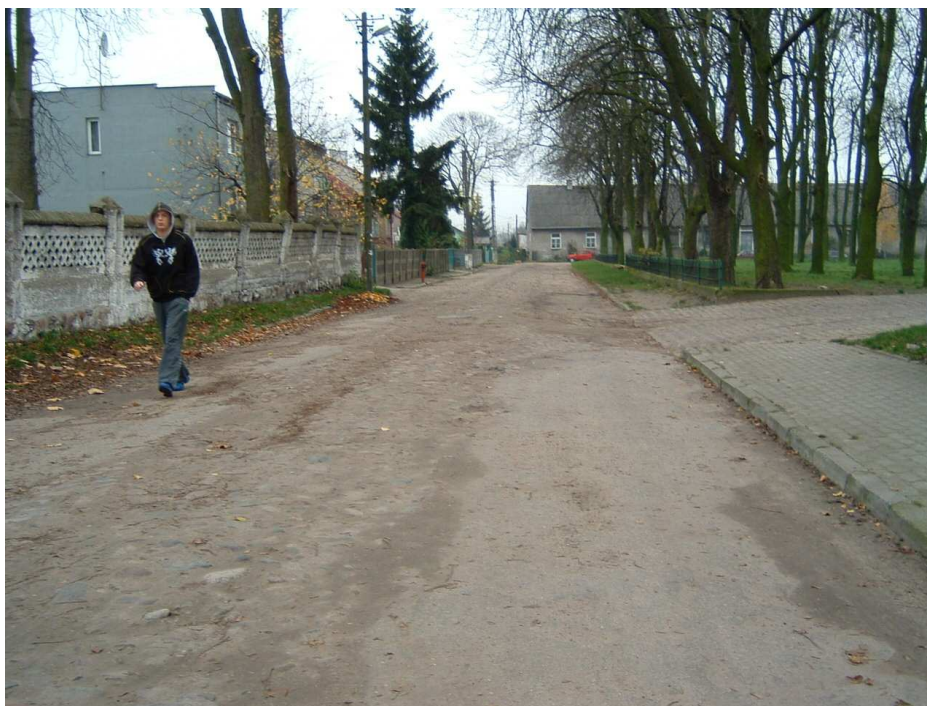
Ciąg pieszo-jezdny od strony północnej parku.
