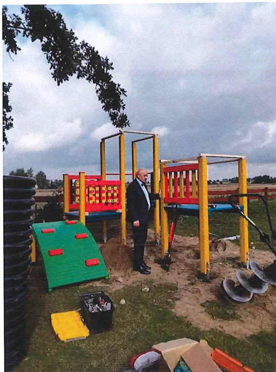
Budowa placu zabaw w sołectwie Niemczewo
