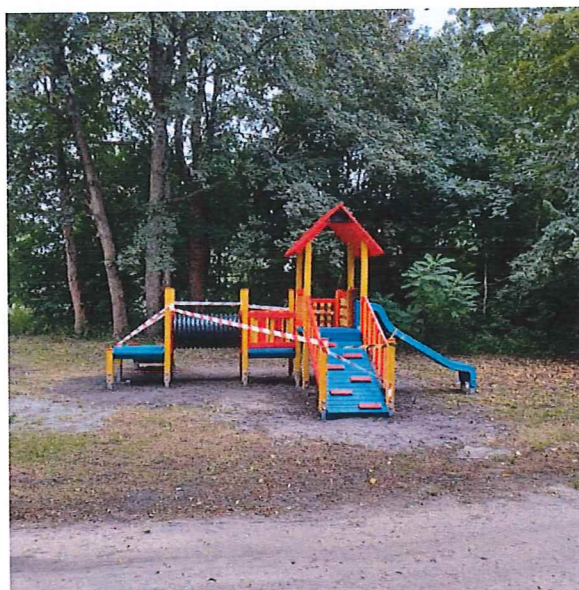
Budowa placu zabaw w sołectwie Biskupice
