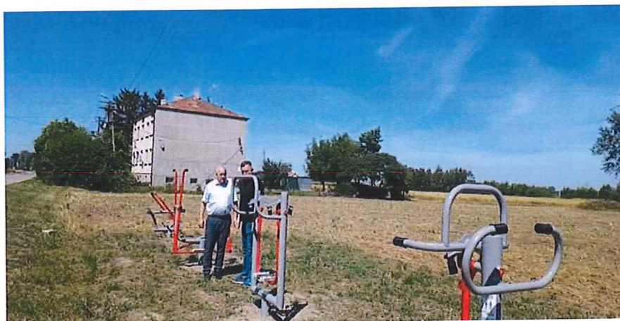
Budowa siłowni zewnętrznej zlokalizowanej na działce o nr 12/6 w sołectwie Cieszewo
