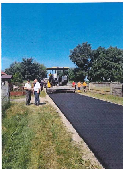
Przebudowa drogi gminnej Nr 290525W w miejscowości Kozłowo-Kozłówko-Łęg Probostwo – V etap
