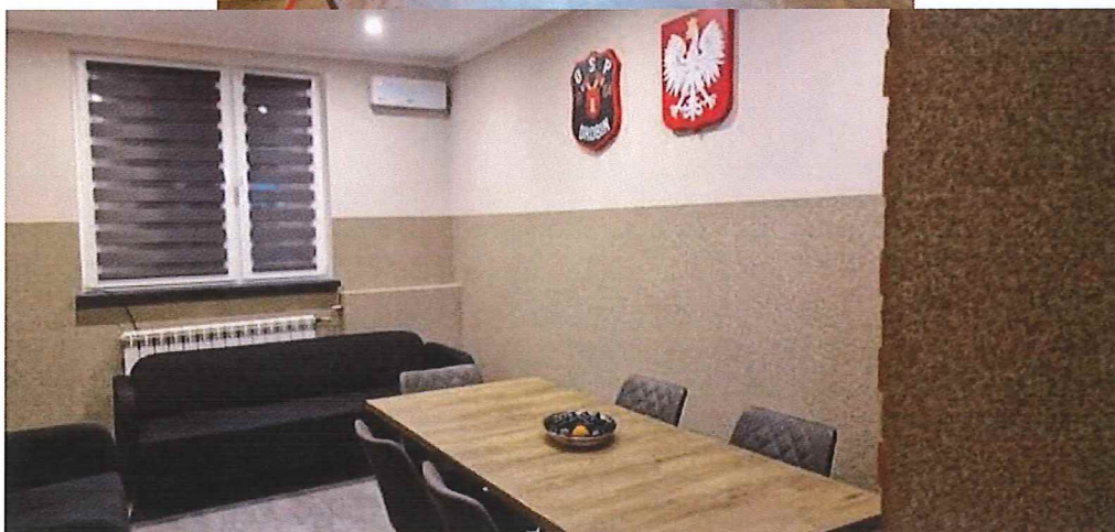
Modernizacja budynku OSP w Drobinie w zakresie ścian, sufitu, stolarki drzwiowej, instalacji c.o. w garażu strażnicy
