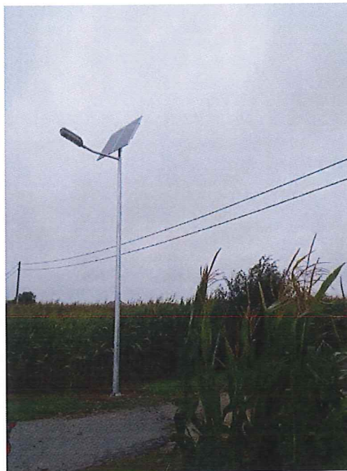
Zakup instalacji służącej użyteczności publicznej - budowa oświetlenia z zastosowaniem technologii LED w sołectwie Tupadły
