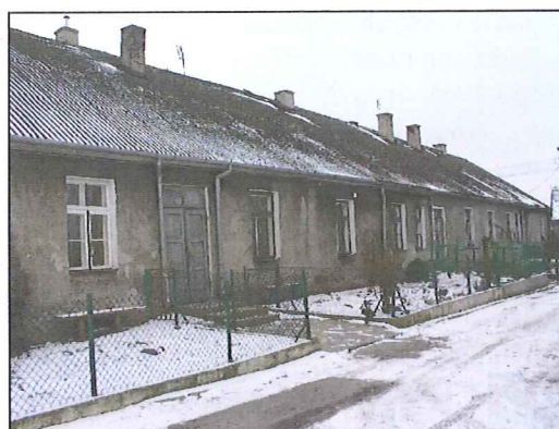
Fot. 7. Dawny zajazd murowany w Drobinie
