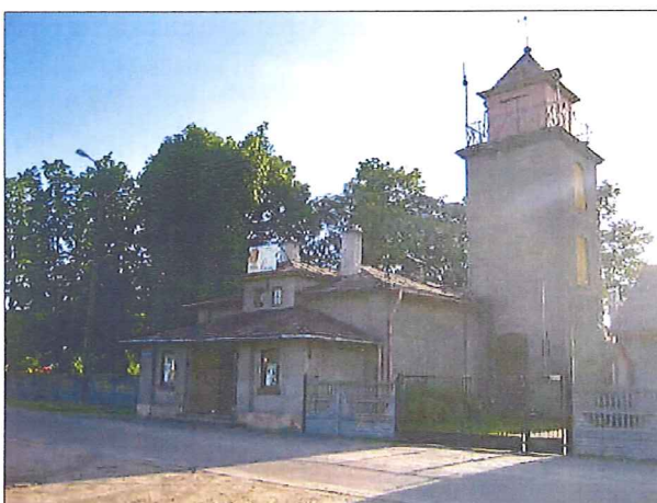
Fot. 14. Budynek straży pożarnej w Drobinie, pl. św. Floriana
