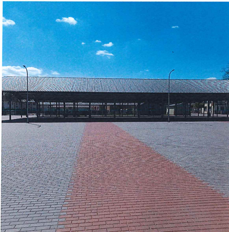
Przebudowa targowiska gminnego w miejscowości Drobin
