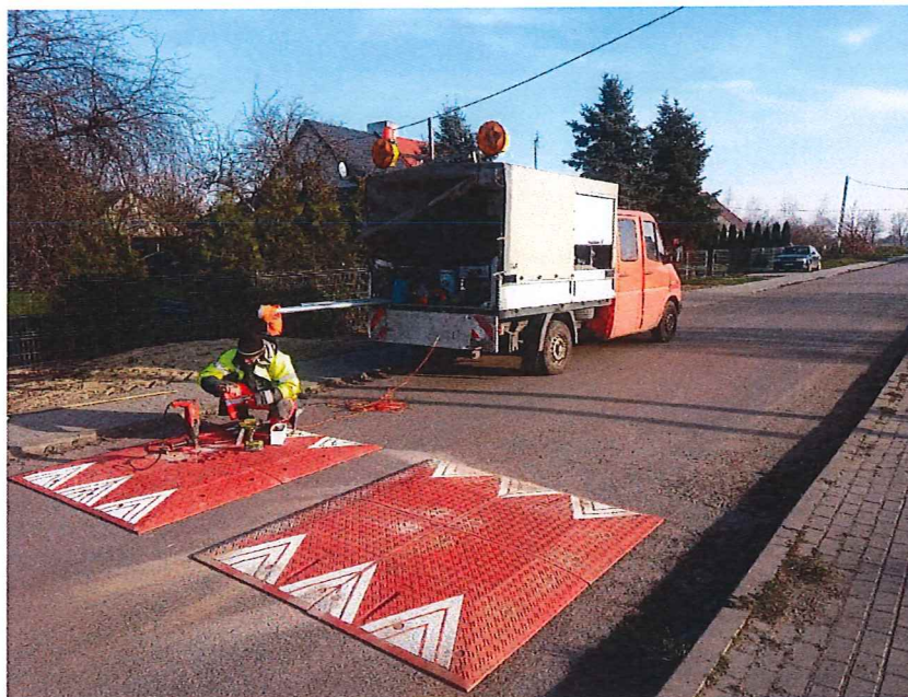
Montaż progów zwalniających na drodze gminnej
