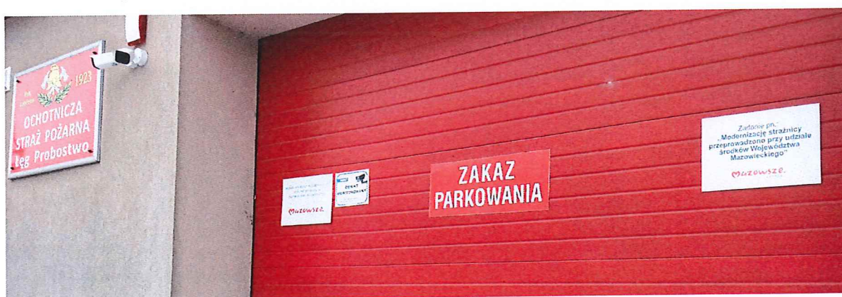
Remont strażnicy OSP Łęg Probstwo.
