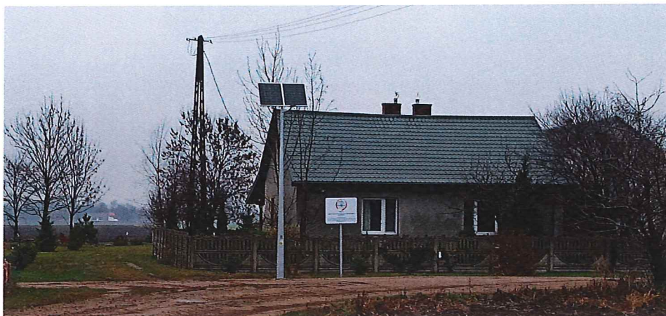
Zakup i montaż lamp solarnych w sołectwie Siemki
