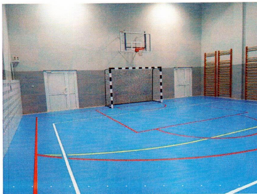
Remont sali gimnastycznej w Łęgu Probstwie
