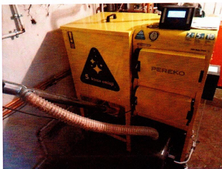
Modernizacja kotłowni indywidualnych
