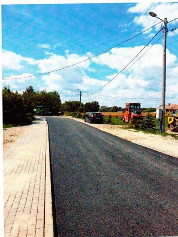
Przebudowa drogi gminnej Nr 290532W w miejscowości Rogotwórk
