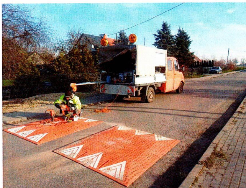
Montaż progów zwalniających na drodze gminnej
