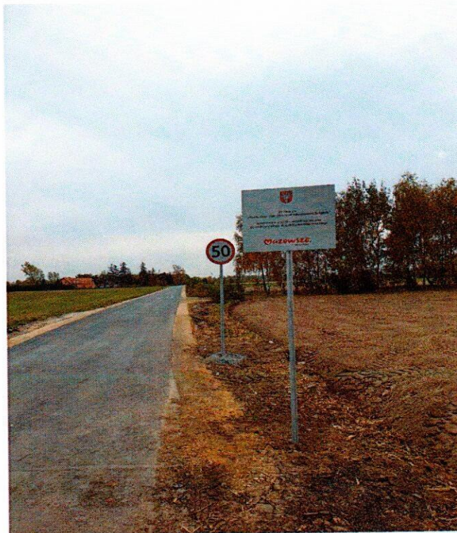
Przebudowa drogi gminnej w miejscowości Sokolniki
