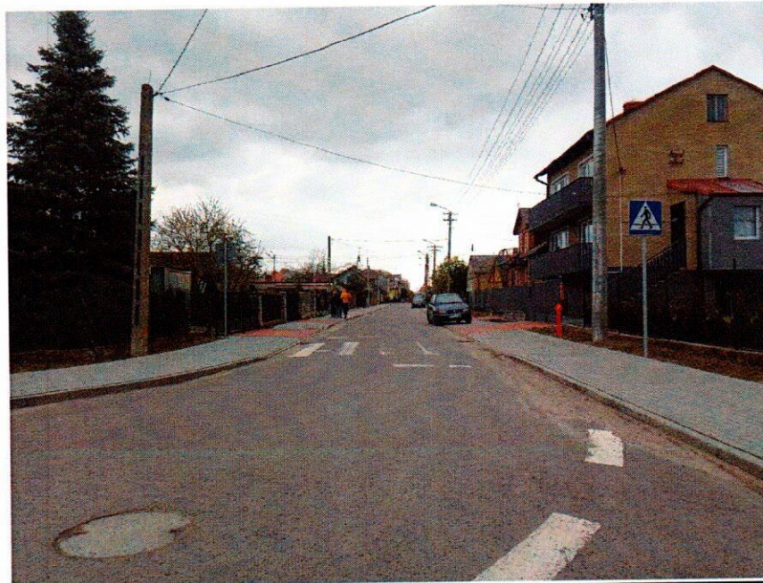
Przebudowa ulicy Gospodarskiej w mieście Drobin
