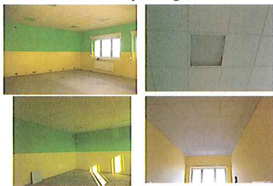
Remont budynku głównego Szkoły Podstawowej w Rogotwórsku
