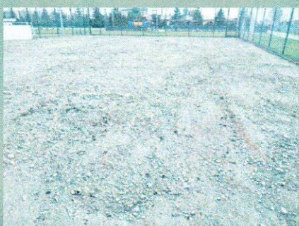
Rozpoczęcie remontu płyty boiska
