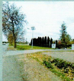
Montaż lamp w technologii LED
