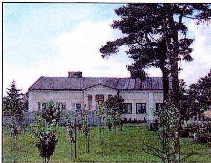
Rysunek 17 Dwór w Łęgu Kasztelańskim [Studium uwarunkowań i kierunków zagospodarowania przestrzennego Gminy Drobin]
